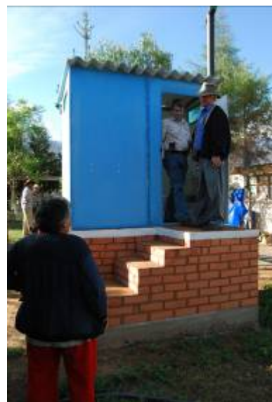
Baño ecológico construido por la Fundación Aguatuya en un barrio de Cochabamba
